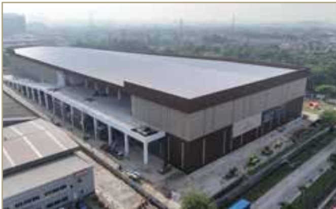
Site progress of Avant Industrial Park
