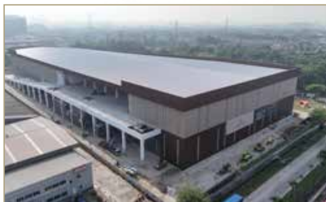
Site progress of Avant Industrial Park
